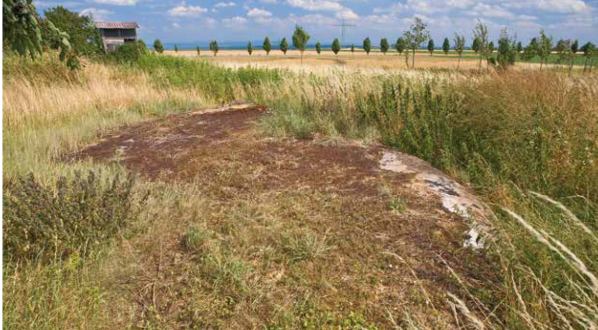
Abb. 272: Decke des Flankierungsbaus von Fort Muhl. Das Gelände ist seit 2006 als Denkmalzone unter Schutz gestellt.
