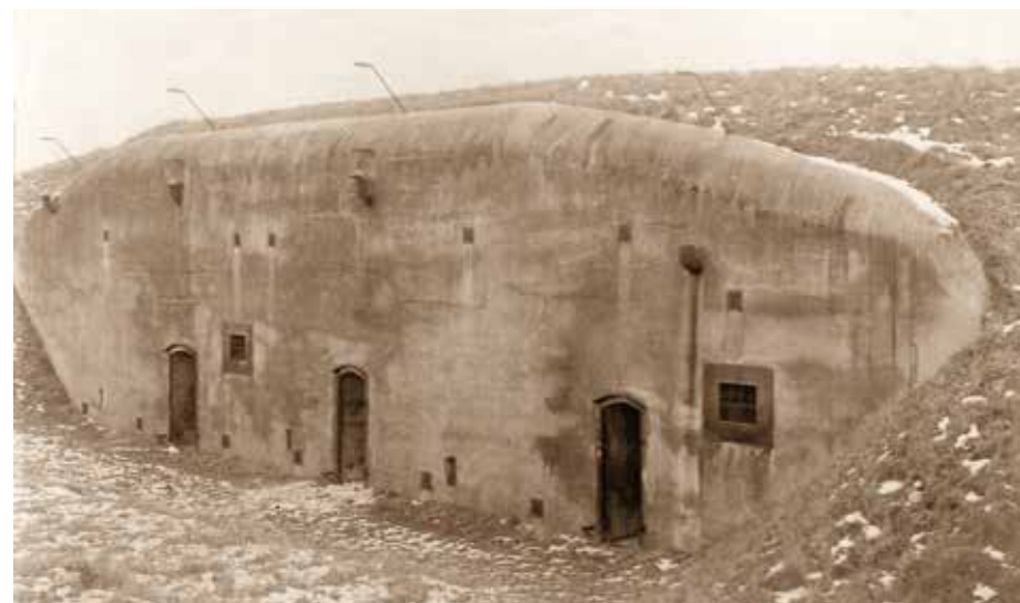
Abb. 110: Munitionsraum MR 12 in Ebersheim. Dieser war baugleich mit dem Munitionsraum MR 4 in Wackernheim. Der MR 12 befand sich an der Ecke der heutigen Nieder-Olmer-Straße und der Peter-Hofmann-Straße.
