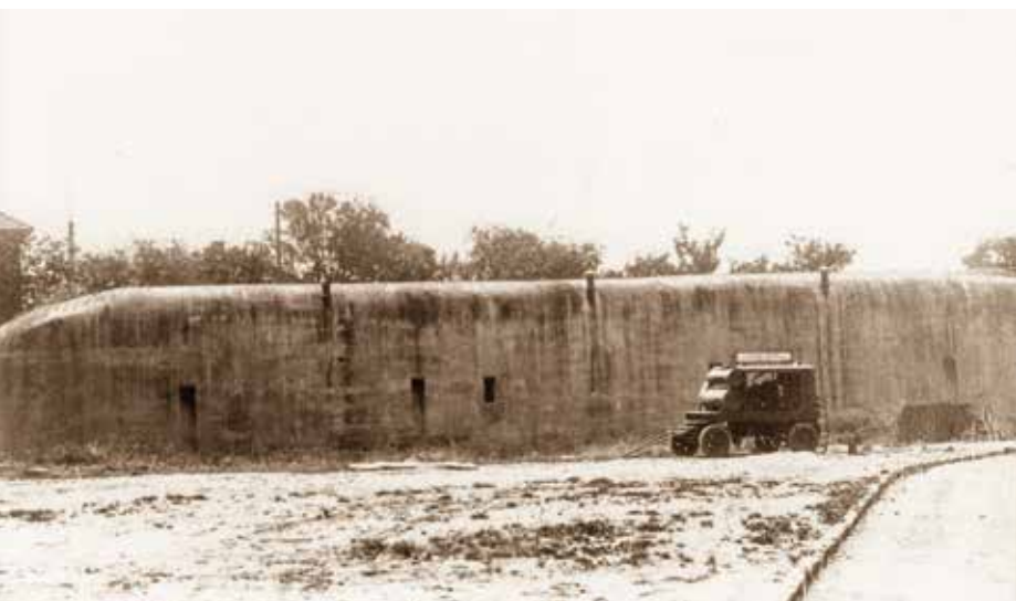
Abb. 109: Munitionsraum MR 4 in Wackernheim. Das Foto ist nach dem Ersten Weltkrieg entstanden und zeigt den oberen Teil des Werkes. Große Teile des Munitionsraums befinden sich unterhalb des Geländeniveaus. Links auf dem Foto ist bereits ein Gebäudeteil des damals neu eingerichteten französischen Flughafen-geländes (später: US-McCully Barracks) zu sehen.
