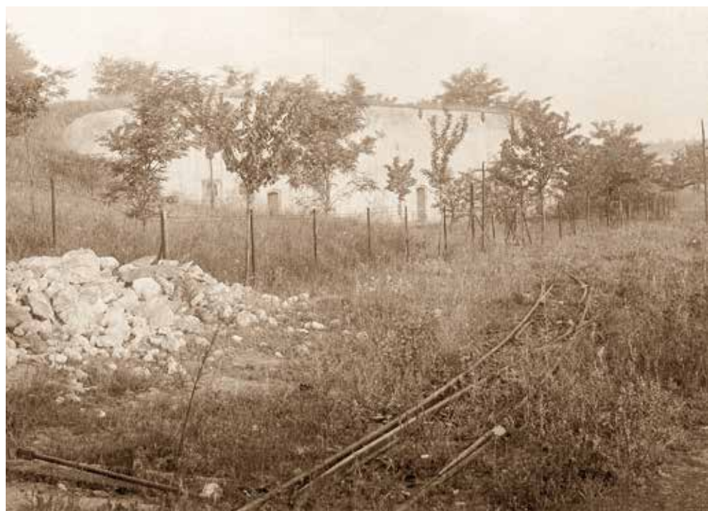
Abb. 102: Munitionsraum auf dem Rabenkopf (Fort Rabenkopf) oberhalb von Wackernheim. Die Anlage war nach dem Fort Muhl das zweitgrößte Werk der Selzstellung und verfügte über einen Bahnanschluss.
